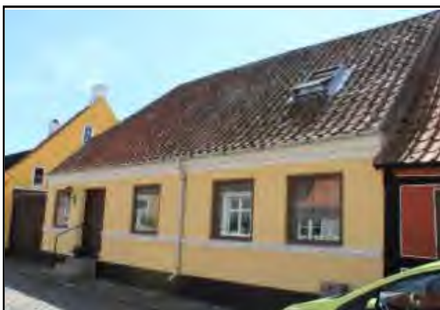
Smedegade 2 Arkitektur 4, Originalitet 4, Miljø 2, Tilstand 2, Bevaring 4 Bygningstype: Byhus Opført: ca. 1900
