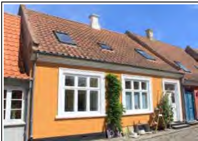
Smedegade 3 Arkitektur 2, Originalitet 3, Miljø 3, Tilstand 2, Bevaring 3 Bygningstype: Byhus Opført: 1915
