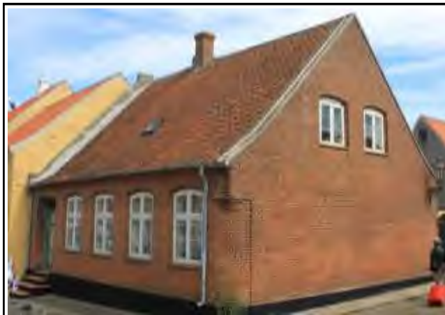
Vestergade 3 Arkitektur 1, Originalitet 2, Miljø 2, Tilstand 3, Bevaring 2 Bygningstype: Traditionelt byhus i 1 etage opført i gadelinien. Opført: 1884 - 85
