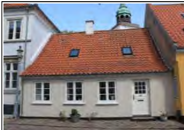
Søndergade 27 Arkitektur 2, Originalitet 3, Miljø 2, Tilstand 1, Bevaring 2 Bygningstype: Byhus Opført: 1806 - ombygget 1921
